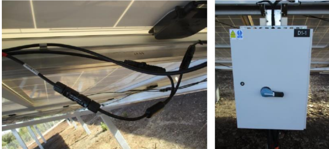
Exemple de câble électrique et de boîte de raccordement - Q ENERGY France
