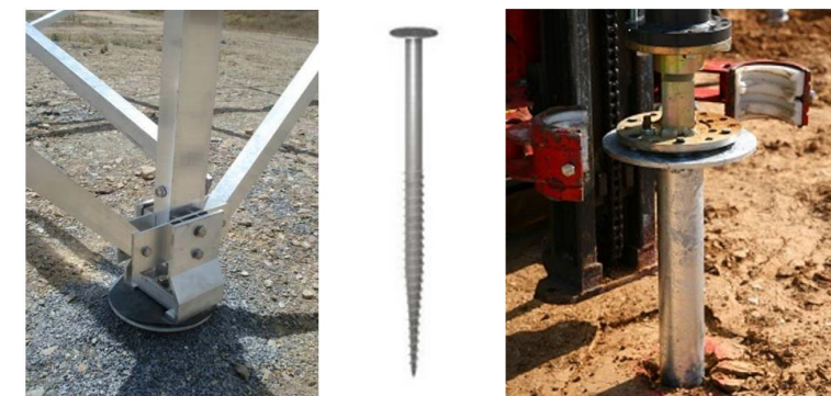
Exemple de fondations à visser - Q ENERGY France
